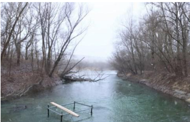
Captarea apei din râul Prut
